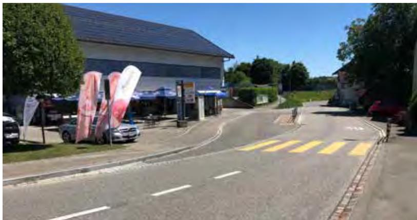
Die heutige Situation mit Busbucht und Insel zum Ein- und Aussteigen der Fahrgäste wird beibehalten. Nach BehiG muss lediglich die Insel mit einem niveaugleichen Einstieg für zwei Türen (Anschlag 22 cm über eine Länge von 9,60m) umgebaut werden.
